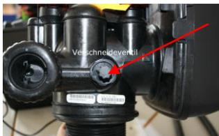
Hierzu müssen sie den Verschneideregler ganz nach links gegen den Uhrzeiger drehen. Jetzt ist die Verschneidung geschlossen. Die Wasserenthärtung bringt jetzt 0-grätiges Weichwasser. Den Test können Sie über den Probeentnahmehahn am Montageblock mit dem Prüfbesteck Gesamthärtemessbesteck vornehmen. Bitte darauf achten, dass das Verschneideventil am Montageblock geschlossen ist.
